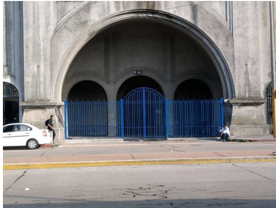
Reja sobre acceso sur izquierdo.
