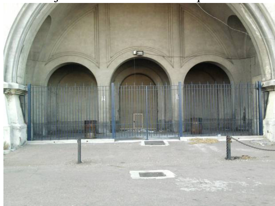
Reja sobre acceso norte derecho.
