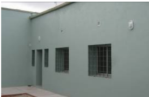
Patio vivienda del administrador
