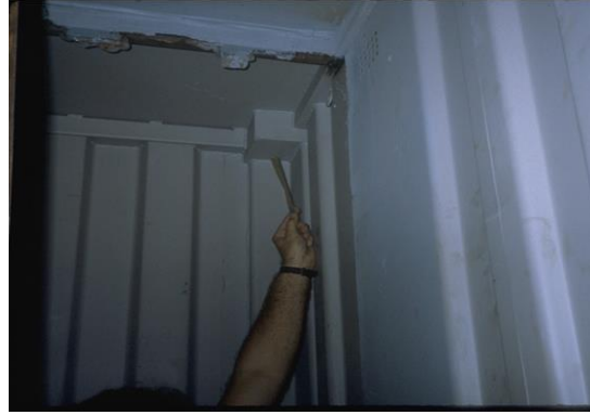
Bloque real oculto detrás de una pared falsa.
