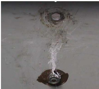
Se utilizan productos químicos para que los pernos se vean viejos y oxidados.
