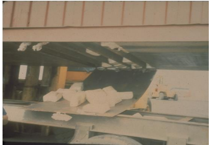
Placa maciza/vigas de soporte no visibles.
