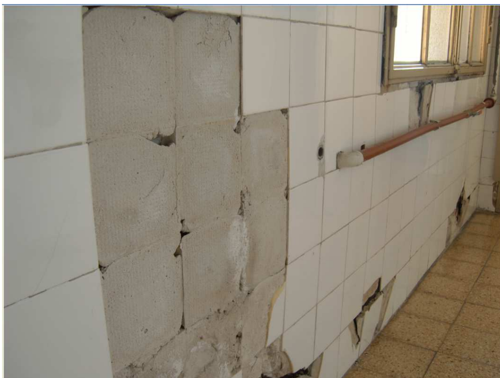
2009 - Situación de baños en general
